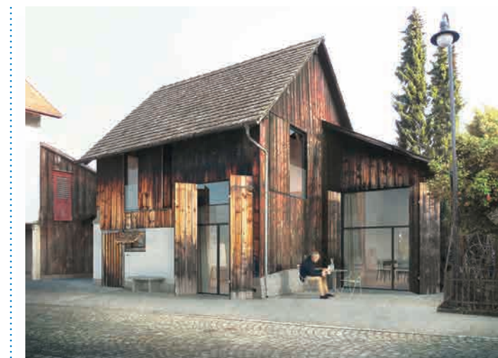
Hauptansicht: Der Schopf soll seine Erscheinung behalten. Die bestehende Schalung wird wieder verwendet. Bild: Architekturbüro Peter Moor GmbH, Zürich
