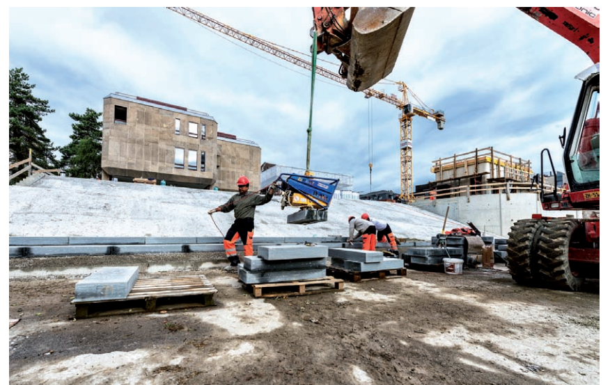
Sorgfältiger Aufbau der beeindruckenden Freitreppe mit Granitplatten der Qualität «San Bernardino Silber». Fotos: Thomas Flück
