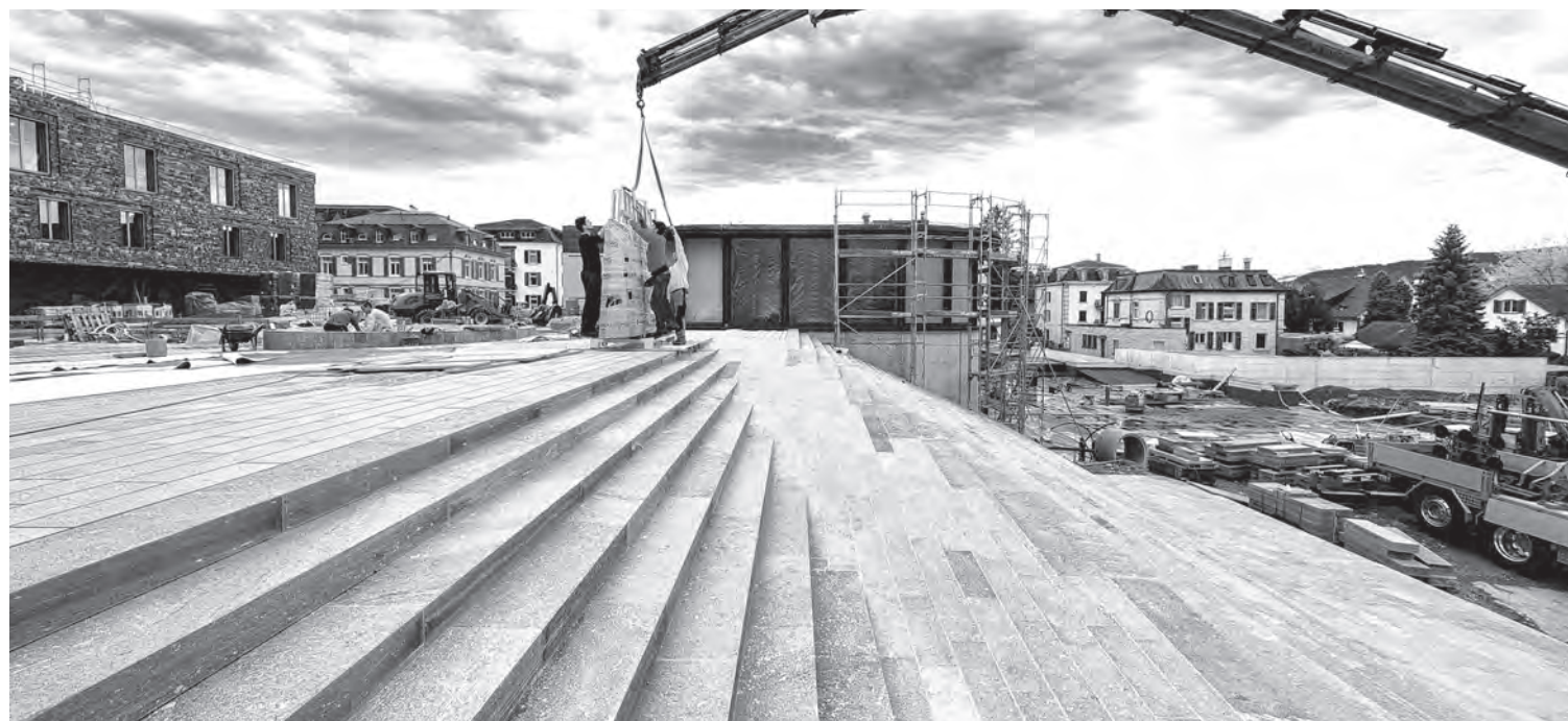
Blick über die fast 30 Meter langen Stufen in Richtung Cafébar, links der neue Gemeindehaus-Anbau.
