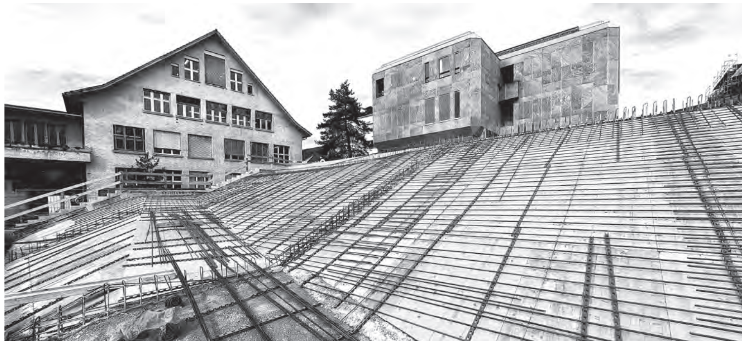
Die Form der neuen Treppe lässt sich bereits erahnen. (Aufnahme von Oktober 2014)
