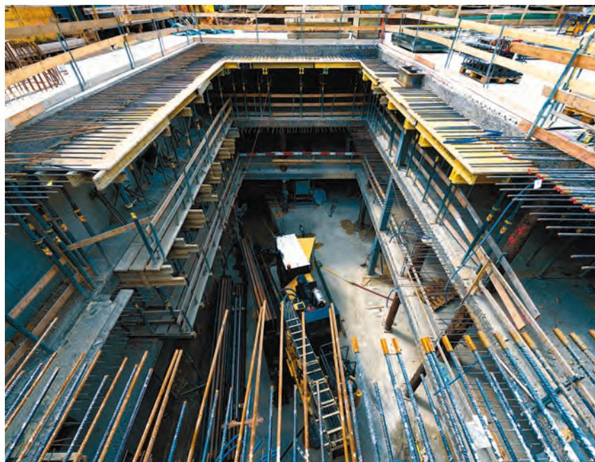
Die Leitung vom See zur Übergabestation im 4. Untergeschoss des Parkhauses wurde im Spülbohrverfahren erstellt.
