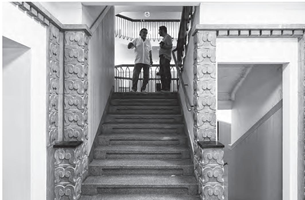
Diskussionen an der Schnittstelle von altem und neuem Gemeindehaus. Das Treppenhaus von 1913 wurde samt Verzierungen integral erhalten. Fotos: Thomas Flück
