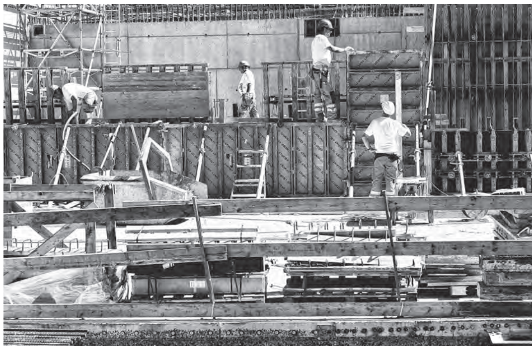
Dutzende von Bauarbeitern waren monatelang auf der Baustelle beschäftigt.
