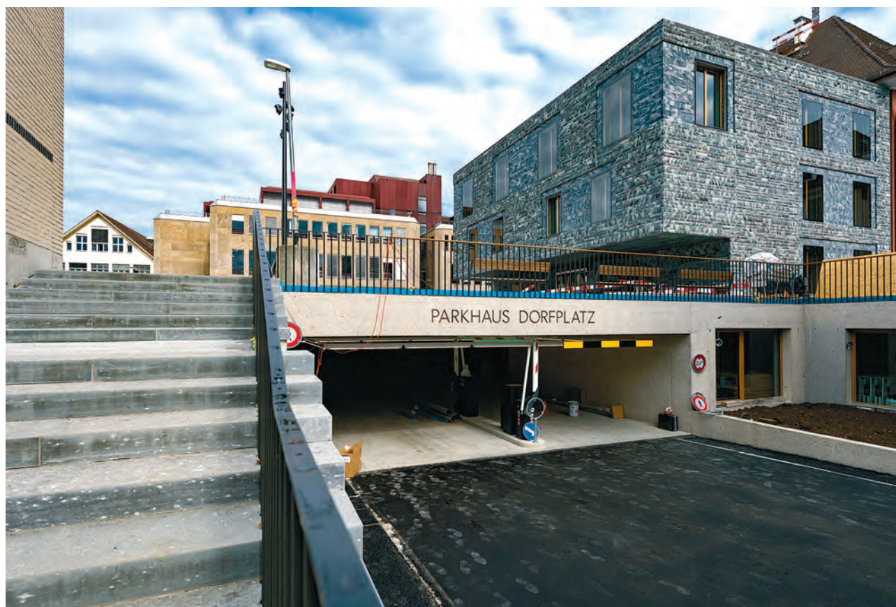
Die Ein- und Ausfahrt zum Dorfplatz-Parkhaus erfolgt von der Bahnhofstrasse her.
