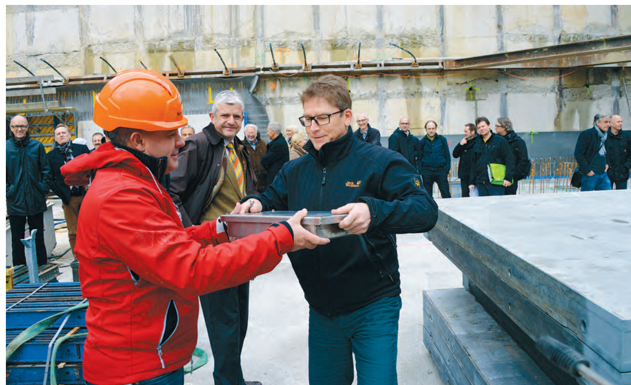
Einer der Meilensteine: Ziemlich genau sechs Monate nach dem Spatenstich erfolgt die Grundsteinlegung. Bauleiter Sandro Cometti überreicht Roman Bühmann, Verantwortlicher für den Aushub, die Box mit den Erinnerungsstücken, die am tiefsten Punkt der Baugrube eingemauert wird. Foto: MAZ
