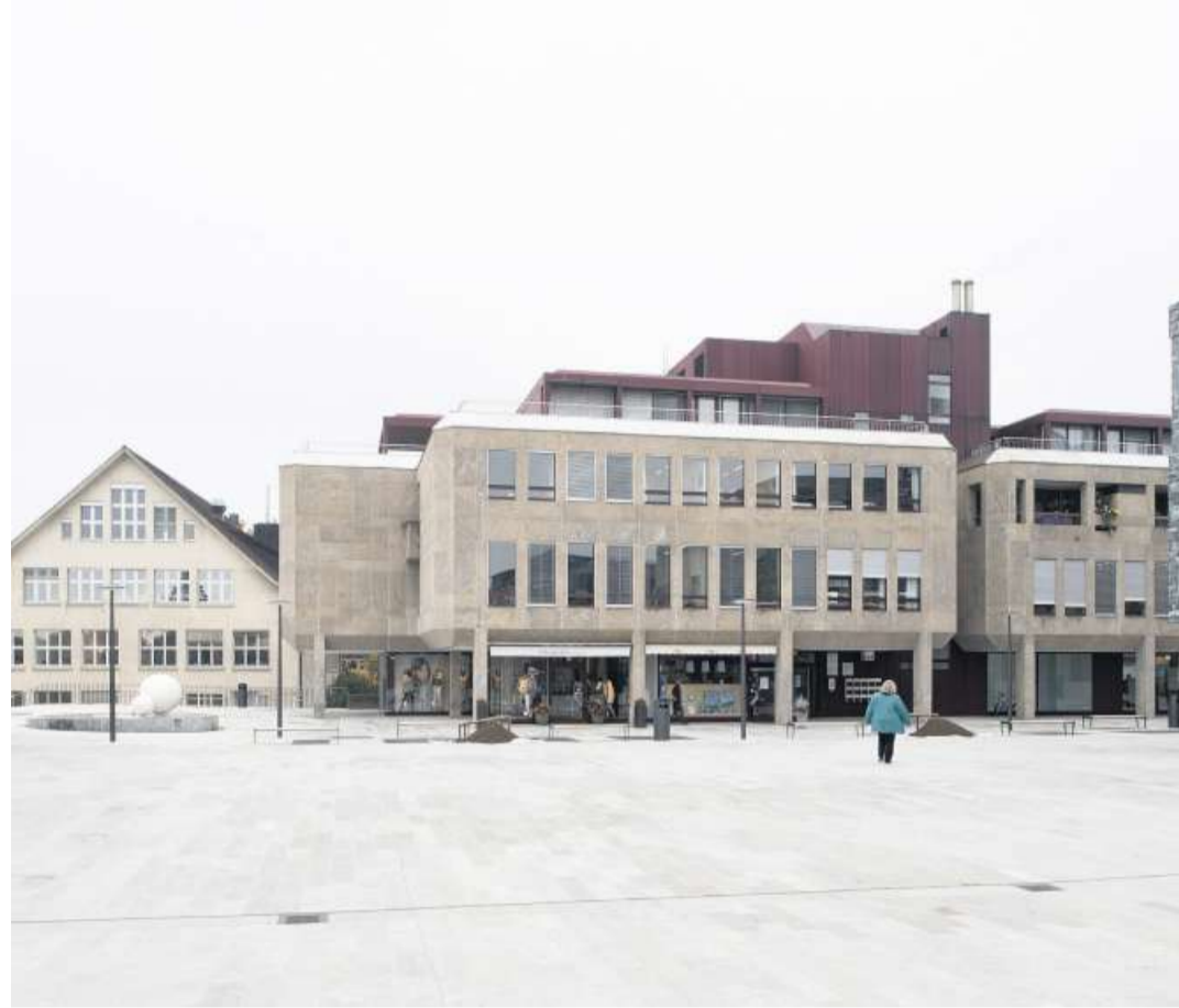
Nach 50 Jahren Planung gibt es in Meilen einen autofreien Platz – nun muss er nur noch belebt werden.
