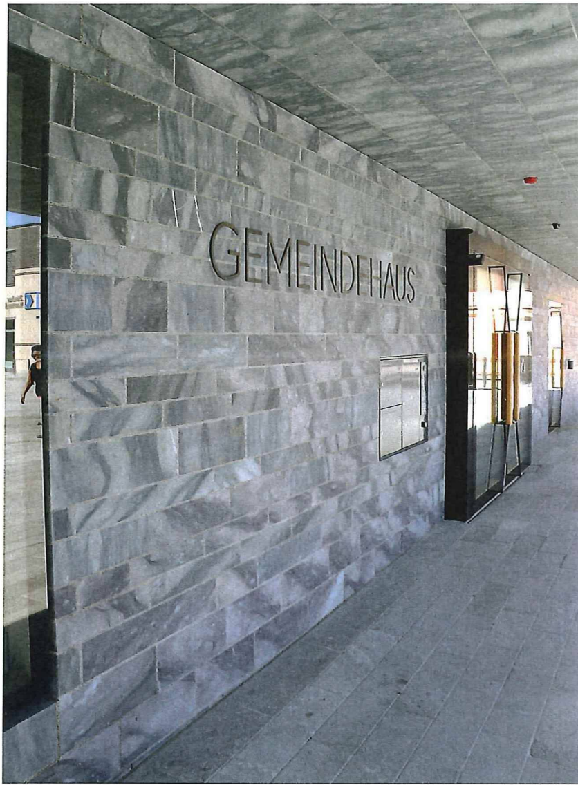
175 Tonnen Blausee-Kieselkalk in Form massiver Mauersteine sind für die Fassade der Gemeindehaus-Erweiterung in Meilen verbaut worden. Im Bild links im Vordergrund die am neuen Standort platzierte Marmor-Brunnenskulptur «Kugelwunder – Wunderkugeln» von Hans Fischli (1909-1989), hier leider ohne Wasser. (Fotos: R. Stadler)
